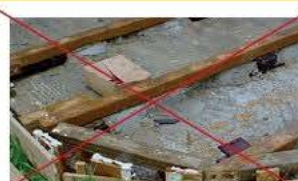
Respecter les joints de dilatation de 10 mm entre les lames
