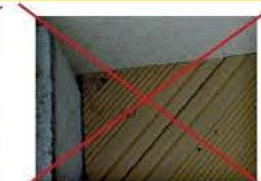
Laisser un joint de dilatation de 5 mm entre les lames et de 15 mm par rapport à un mur ou un obstacle.
